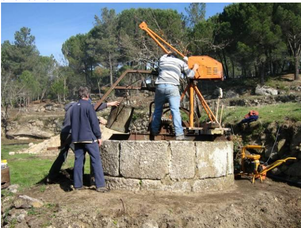
Mbv. de lier en het bakje wordt het vuil uit de put omhoog gehaald, tevens dient het als vervoermiddel voor de schoonmaker, Paulo.
